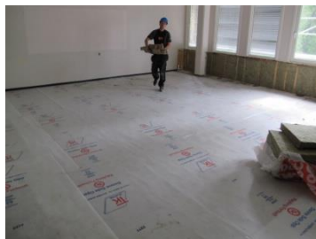
Beskyttelse av gulv under rehabilitering
