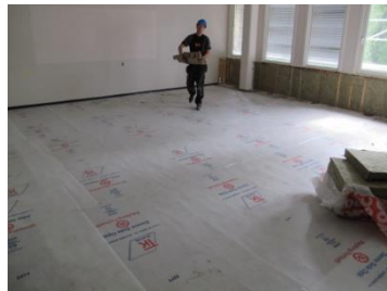
Beskyttelse av gulv under rehabilitering
