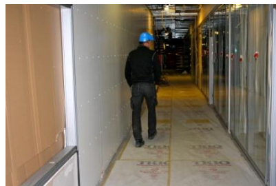
Beskyttelse av nytt gulvbelegg i korridor på en ny skole
