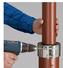
Elektrisk eller trykkluftskrutrekker kan benyttes.
