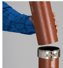
Skyv inn det andre røret slik at det treffer midtrillen.
