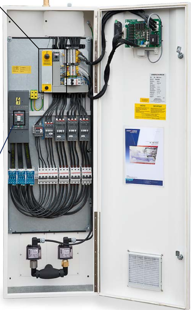
Elektrokjelen EL160 Eco med innebygd sikkerhetssystem.
