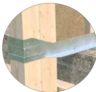
Stender med utsparing for dekker når dekket ikke kan avsluttes på innsiden av vegg. Bjelkesko for I-bjelker festet direkte til dekket.
