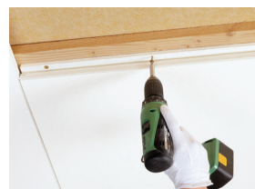
Master F monteras med skruv
