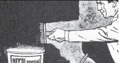
**DNK** - Tag en håndfuld Sement X i hånden. Brug gummihandsker. Pres pulvert mod lækagen. Mød vandstrømmen med en hurtig bevægelse.
