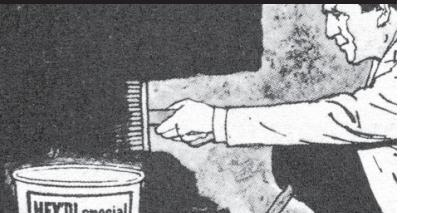
**NOR** - Så snart påføringen av Sement X er fullført, påføres Forseglingsvæsken med en rengejert pensel. Væsken trekker seg gjennom de påførte sementlag og inn i muren, poreetter denne ved krySTALLisering, og forankrer tettingen.
