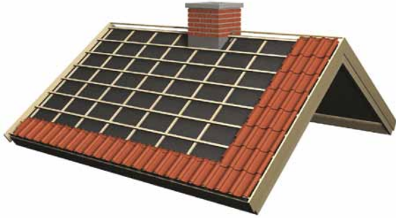
Bilde 6. Fortsett med to til tre rader av gangen fra takfot til mønet. Kontroller at radene er rette.
