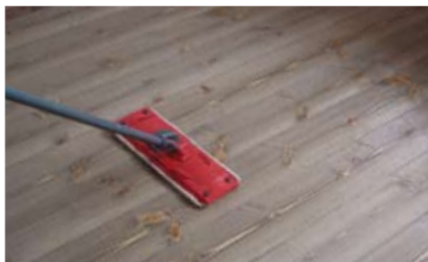
Stryk middelet umiddelbart utover gulvet. Arbeid inn tynne lag i gulvets lengderetning
