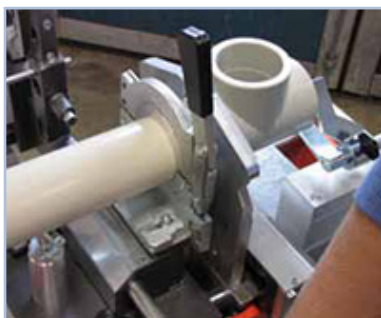
Lim sammen rør og muff.
