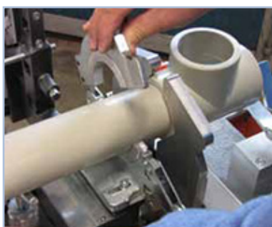
Monter røret i sveisemaskinen etter maskinens anvisninger.
