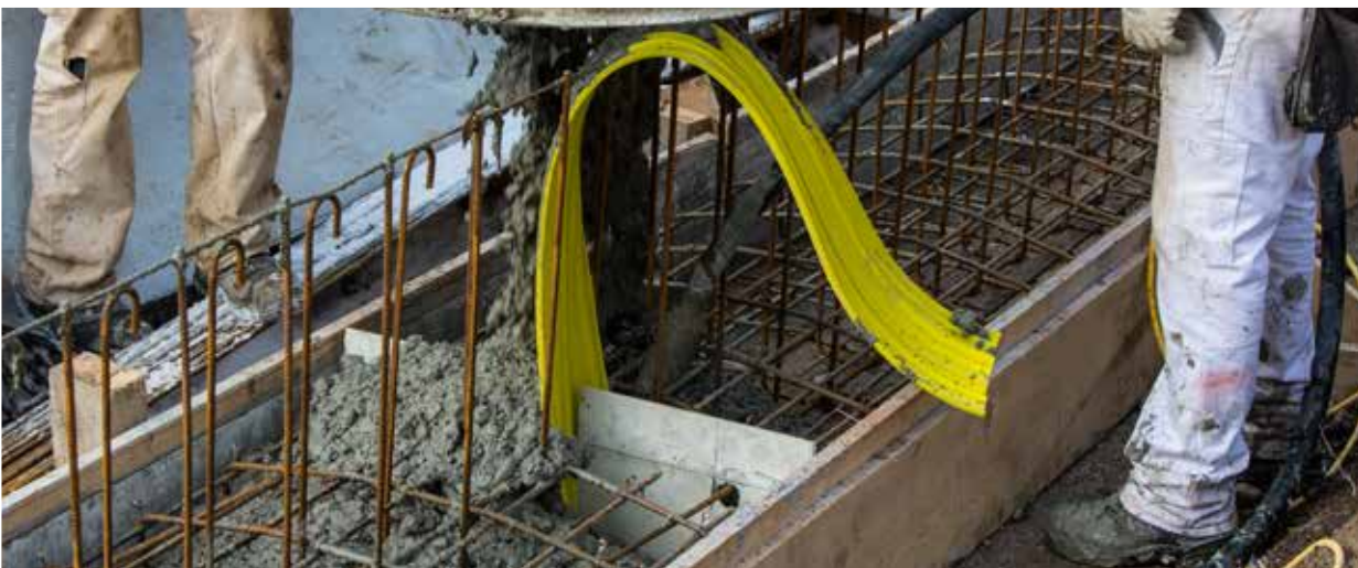
Sika "White Box"-konsept / Vanntett betong
