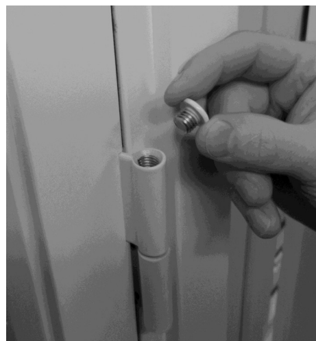
Fig 21. Demontering av dekklokk på toppen av hengsler.
