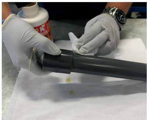
Tørk av overflødig lim.
