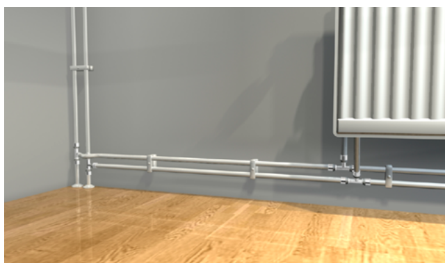
Eksempel på fiksering ved synlig forlegning.
