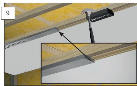
Fra og med plate nr 2 **skal** det benyttes Forestia styreskinne. Det er avgjørende at platene ligger helt jevnt med hverandre for å få et bra resultat. Styreskinnen holdes på plass i profilen når du slår på slagklossen for å drive platene tett sammen (vær Obs så styreskinne ikke faller ned under bruk!).
