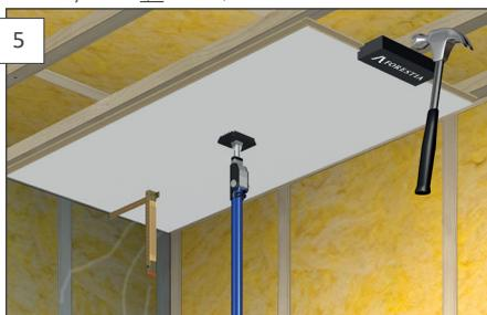
Bruk takstøtte for å holde opp platene ved monteringen. Forestia slagkloss **må** benyttes for å ikke ødelegge profilen når plata skal slås på plass. Denne slagklossen er tilpasset platens profil. Vis varsomhet når Forestia slagkloss benyttes.
