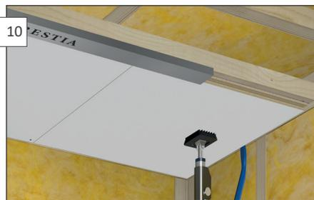
For å få på plass siste plate, benytt et brekkjern for å lukke profilen. Benytt styreskinne for siste justering.
