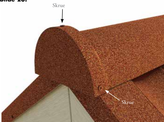
Montering av mønestart
