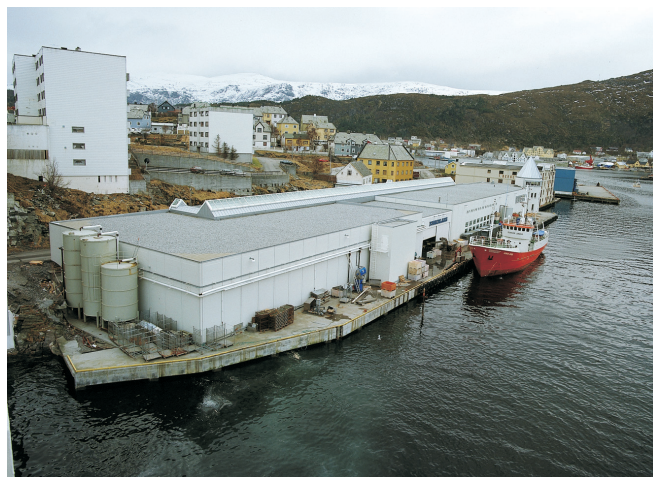
Kjøleinstallasjoner hos Fjordlaks AS
