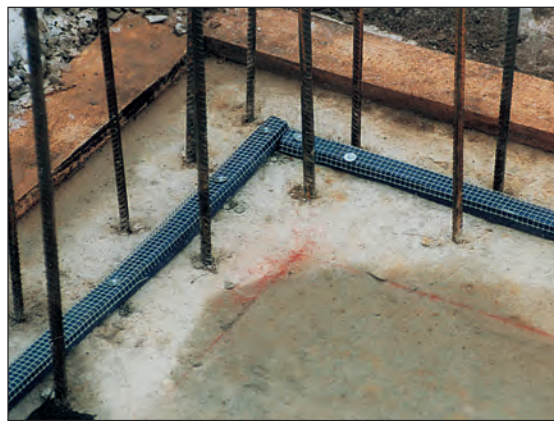
Montering med festegitter og spiker
