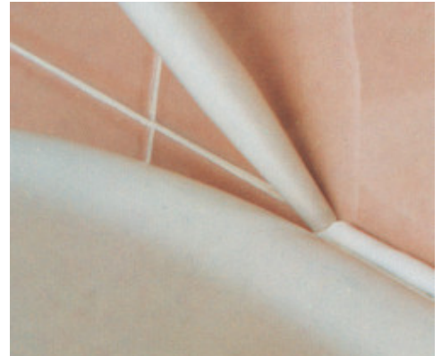
Fuging mellom sanitærutstyr og keramiske fliser
