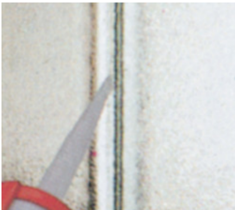
Fuging av 2 lags glass
