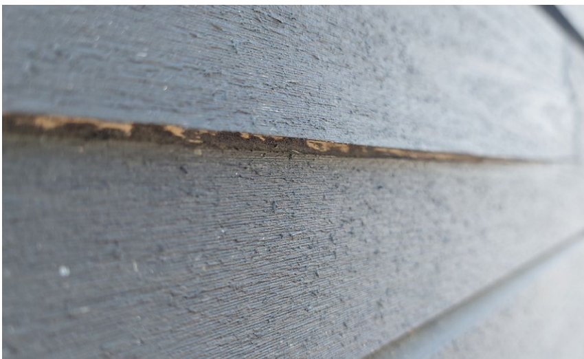
Bilde 14 - Formforandringer i årringer. Formforandringer i årringer er vekstbetinget og viser seg som åpninger i treet mellom vårveden og høstveden. Dette kan forekommer når treet eksponeres på fasaden.
