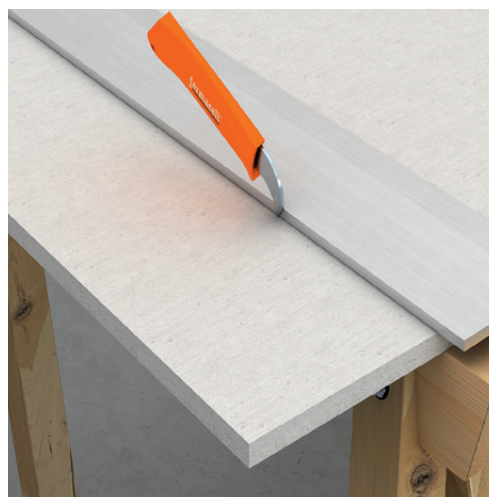
2. Rissing med Fermacell rissekniv
