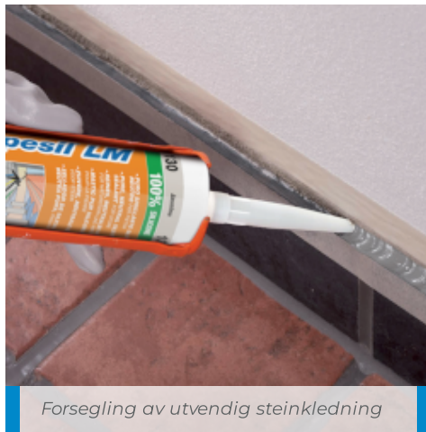
Fuging av fasadefuger med Mapesil LM
