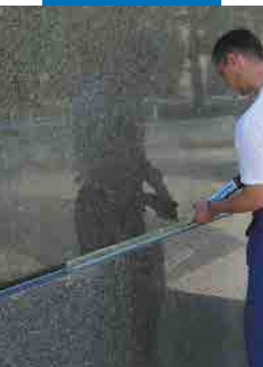
Fuging av en fasadeskjøt med Mapesil LM
