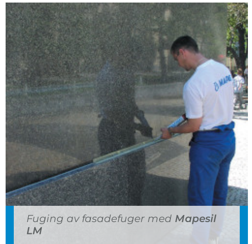
Forsegling av utvendig steinkledning
