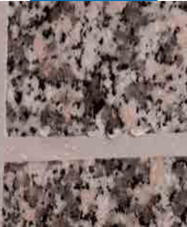
Fuging av fliser utendørs
