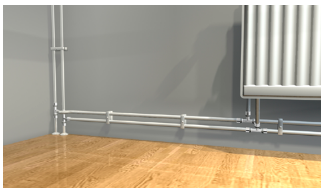
Eksempel på fiksering ved synlig forlegning.
