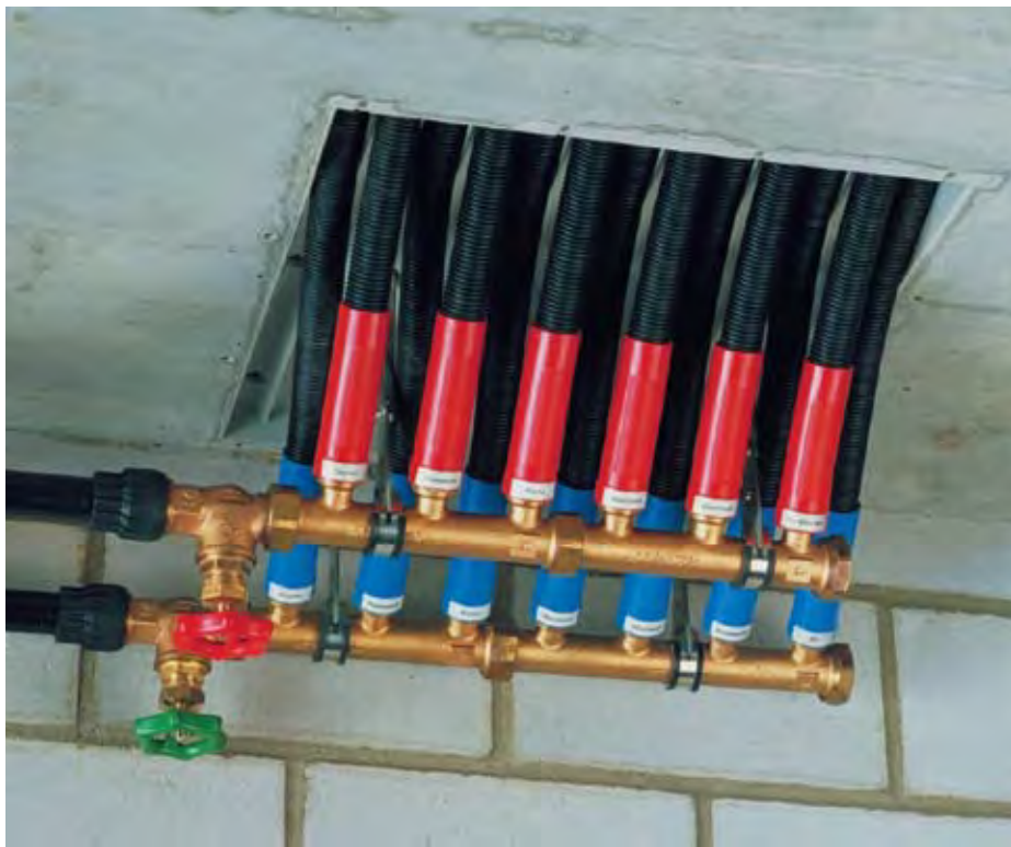
Et eksempel på overgang fra Sanipex MT til Sanipex Classic
