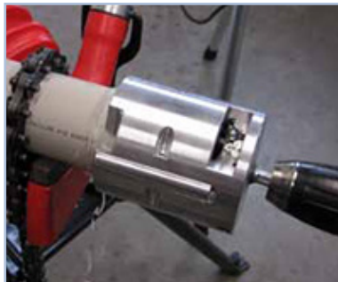
Skrap utsiden av røret.
