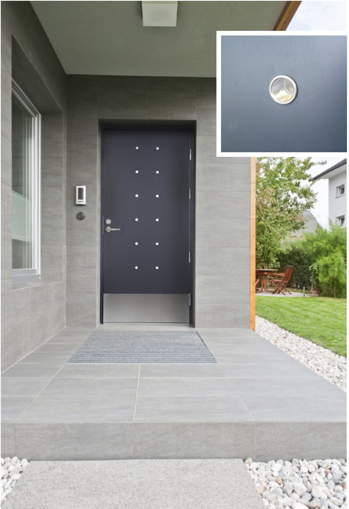
Inngangsparti med Fjell 02 i grå NCS S 6500-N. Fjell 02 har 12 akrylstavar, som slepp lys gjennom dørbildet.
