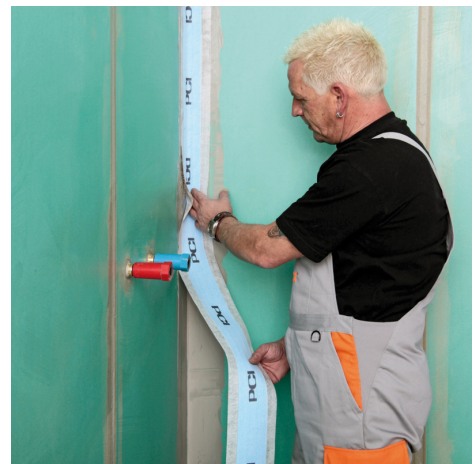
PCI Pecitape legges ned i det ferske laget med det brukte membranmaterialet.
