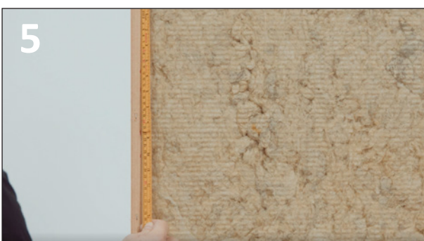
5 STIFTEAVSTAND PÅ STENDERE - 20CM. BENYTT HUNTONIT SKRUE ELLER KRAMPER MIN. 30MM
