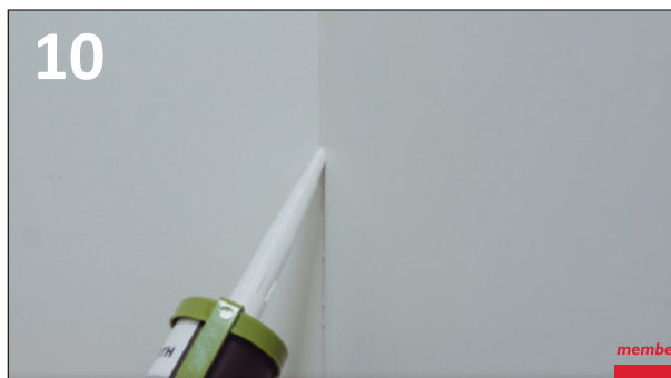
10 HUNTONIT AKRYLMASSE ANBEFALES TIL INNVEINDIGE HJØRNER
