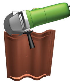
Bilde 10. Det er viktig å slipe bort litt av undersiden på taksteinen, slik at taksteinen ikke blir liggende å "ri" på taktillbehør.
