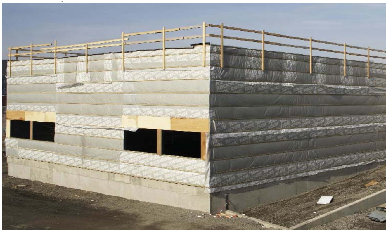
Rockwool Vindsperre benyttet på industribygg
