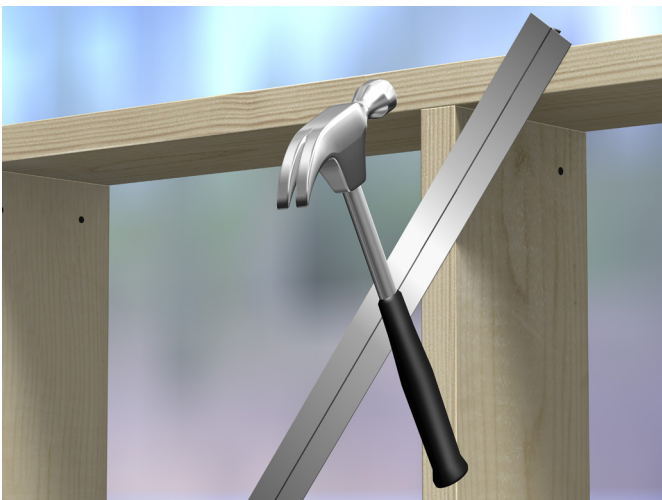
Fig. 31 Avstivningsstag bankes inn i slissen
