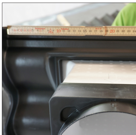
1. Mål ut fra lektheholder til senter rør.
