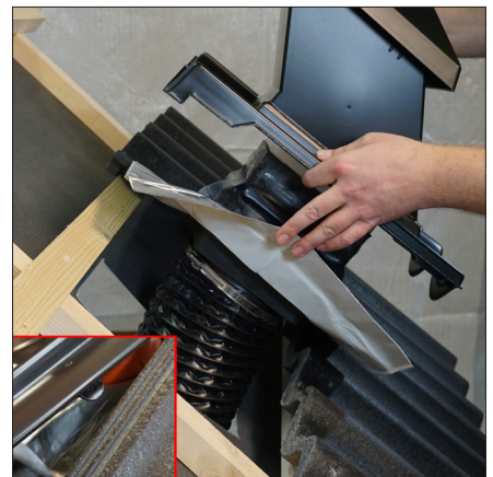
6. Tre flexislange igjennom hullet og legg hatten på plass. Fest hatten til takstein med klemme.
