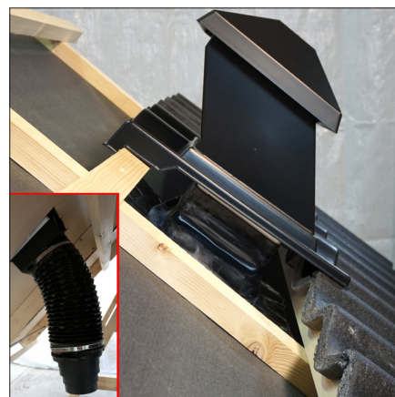
8. Ferdig montert. Fest alle omliggende stein med stormklips.
