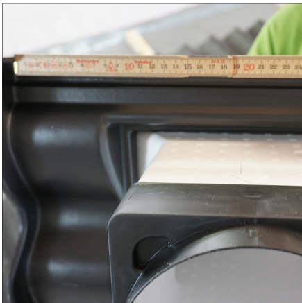
1. Mål ut fra lektheholder til senter rør.
