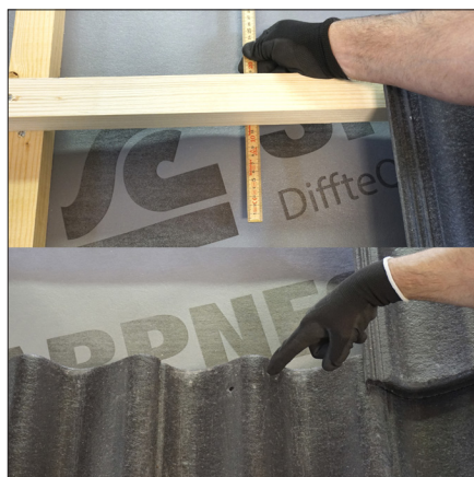
2. Marker målet fra topp lekte. Marker midt på takprofil.
