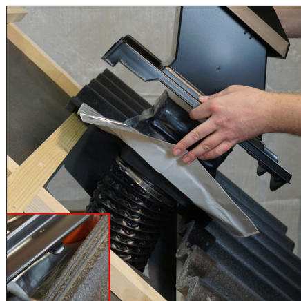
6. Tre flexislange igjennom hullet og legg hatten på plass. Fest hatten til takstein med klemme.
