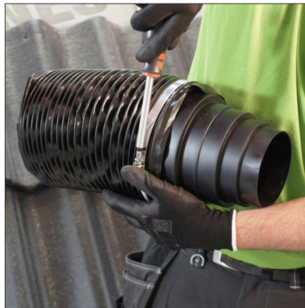
5. Sett på multiadapter og flexislangen på hetten og fest med slangeklemme.
