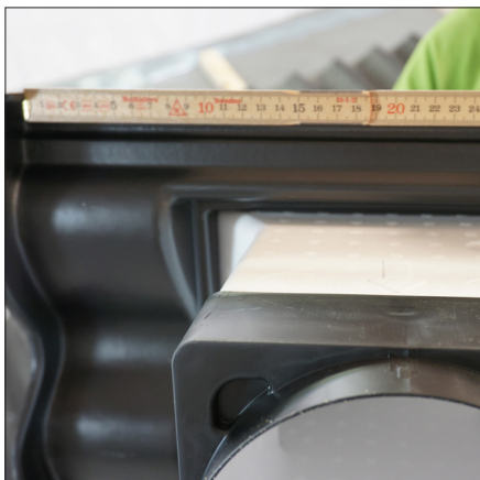
1. Mål ut fra lektheholder til senter rør.
