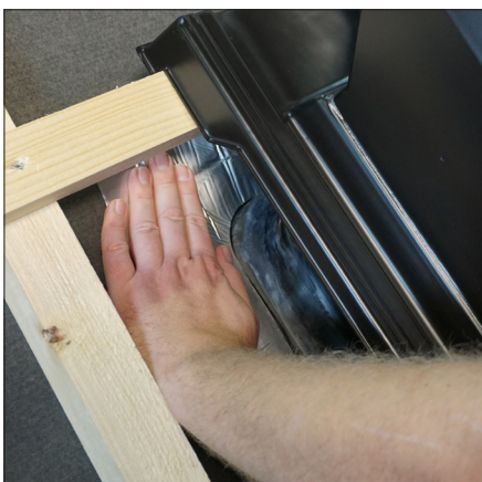
7. Fjern evt. støv fra undertak. Dra av folien på mansjett, klem fast og glat ut ujevnheter.
