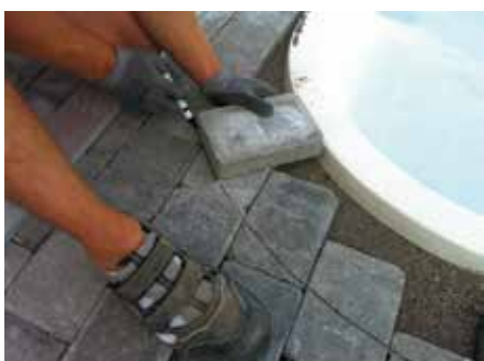
7. Lag god nok avstand til fugesand og ekspansjon.
