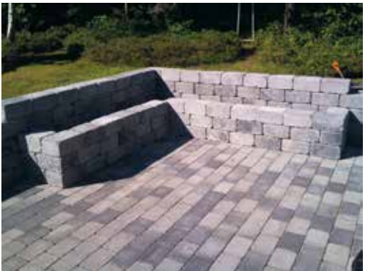
Det ble valgt tre skift til sete og fem skift til rygg fordi dette passet eier i høyde, men det er selvfølgelig mulig å bygge høyere. Det kan da være lurt å lime steinene med Scan Steinlim for bedre stabilitet.
