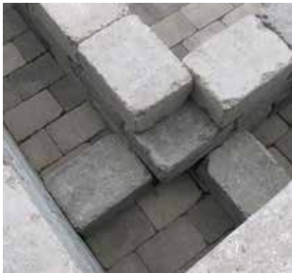
Eksempel på støttestein i hulrommet. Disse ble bygget helt opp til siste skift så benken i treverk har noe å hvile på.
