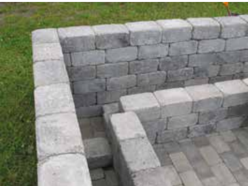
Eksempel på støttestein i hulrommet. Disse ble bygget helt opp til siste skift så benken i treverk har noe å hvile på.
