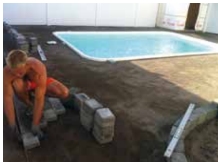
2. Bruk god tid på planleggingen av leggemønster og retninger. Bruk snor og målestokk.
