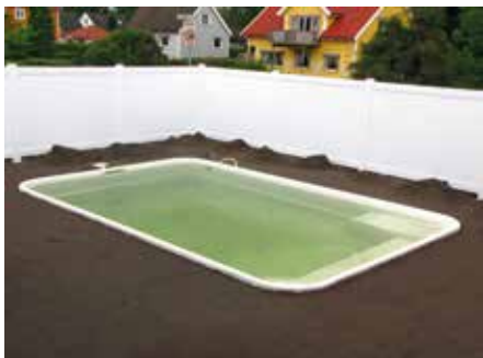
1. På arealet som skal steinlegges, er ferdig masse byttet ut, grovavrettet og komprimert. (se side 56-57 for leggveiledning)
