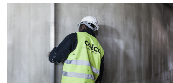
OVERFLATEBEHANDLING PÅ INNERVEGGER SIDE 10
