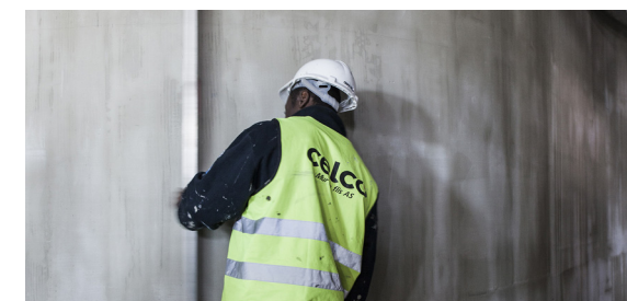
OVERFLATEBEHANDLING PÅ INNERVEGGER SIDE 10
