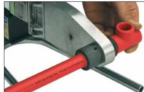
Oppvarming av rør og rørdel
