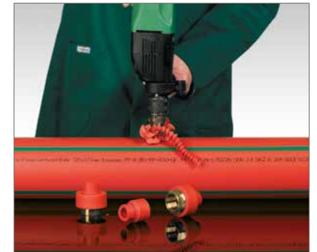
Gjennom boring av røveggen
