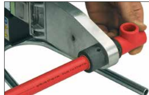
Oppvarming av rør og rørdel
