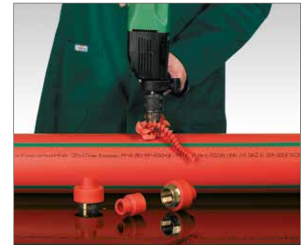
Gjennom boring av røveggen
