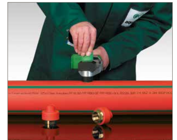
Oppvarming av rør og rørdel
