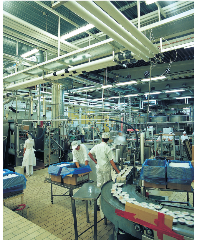
Industri-installasjon ved Hennig Olsen AS
