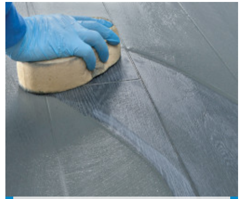
Vasking av fuger med hard svamp (spongo)
