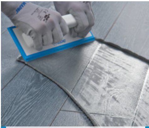
Fuging av Ultracolor Plus på fliser med trestruktur med gummibrett
