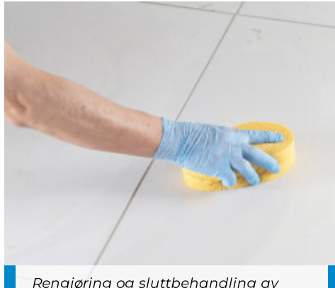
Rengjøring og sluttbehandling av fugene med hard cellulose svamp (spongo)
