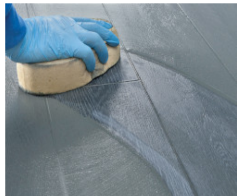
Vasking av fuger med hard svamp (spongo)
