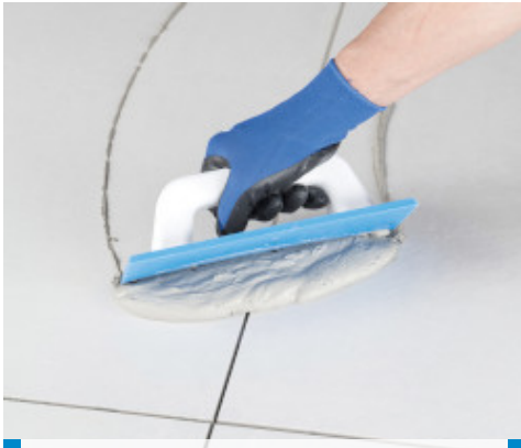
Fuging av Porselenato fliser med Ultracolor Plus
