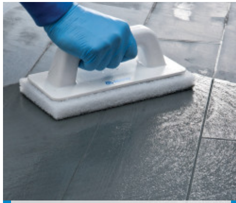
Vasking av fuger med Scotch-Brite® skurepute (produkt delvis herdet)
