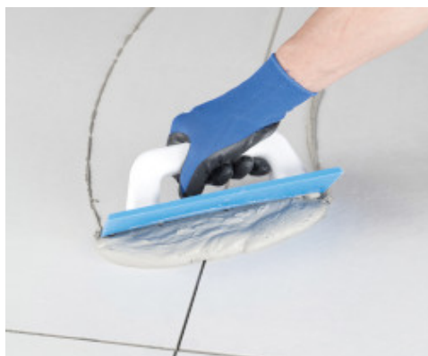
Fuging av Porselenato fliser med Ultracolor Plus
