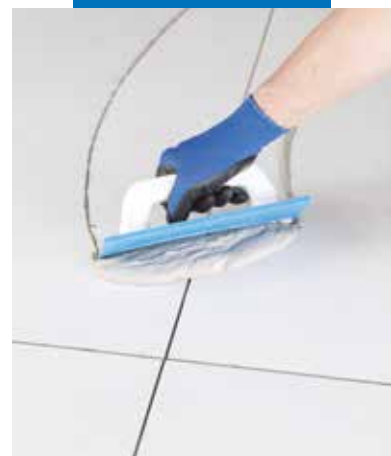
Fuging av porselen fliser med Ultracolor Plus
