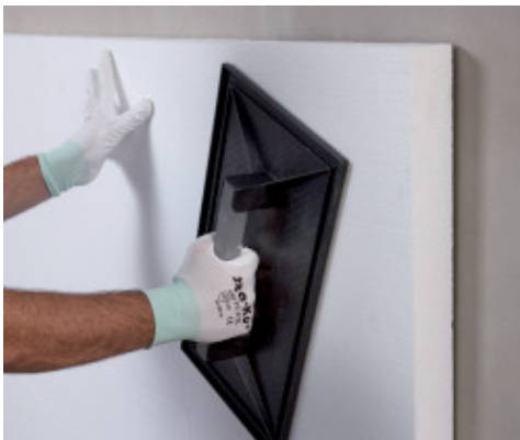
Platen presses på plass for å sikre god heft til underlaget
