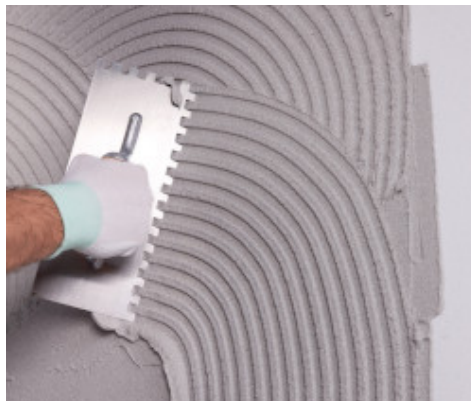
Første lag avrettingsmasse legges med Mapetherm AR1 GG
