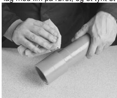
Tørk av overflødig lim.
