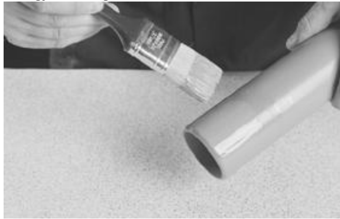
Lim på med pensel i lengderetning. Legg et tykt lag med lim på røret, og et tynt et i muffen.
