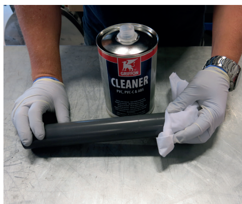
Rengjør rør og rørdel.
