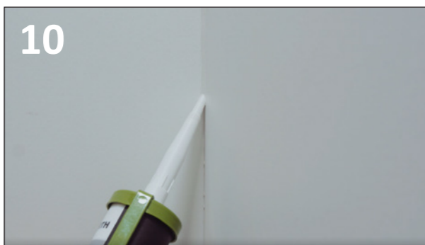
10 HUNTONIT AKRYLMASSE ANBEFALES TIL INNVEDIGE HJØRNER.
