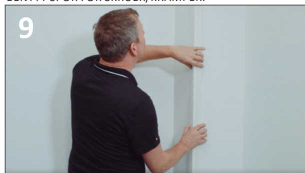
9 VELEGNET TIL LISTEFRIE LØSNINGER. VED UTVENDIG HJØRNE ANBEFALES SELVKLEBENDE FLEX LIST.
