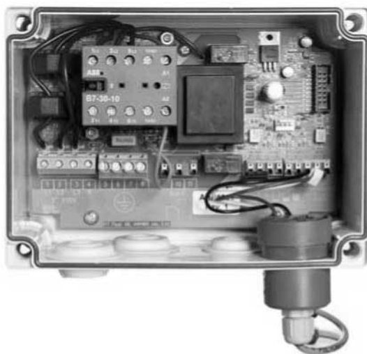
Figur 3: En ferdig installasjon
