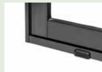
Utløp fra skjult dreneringskanal
