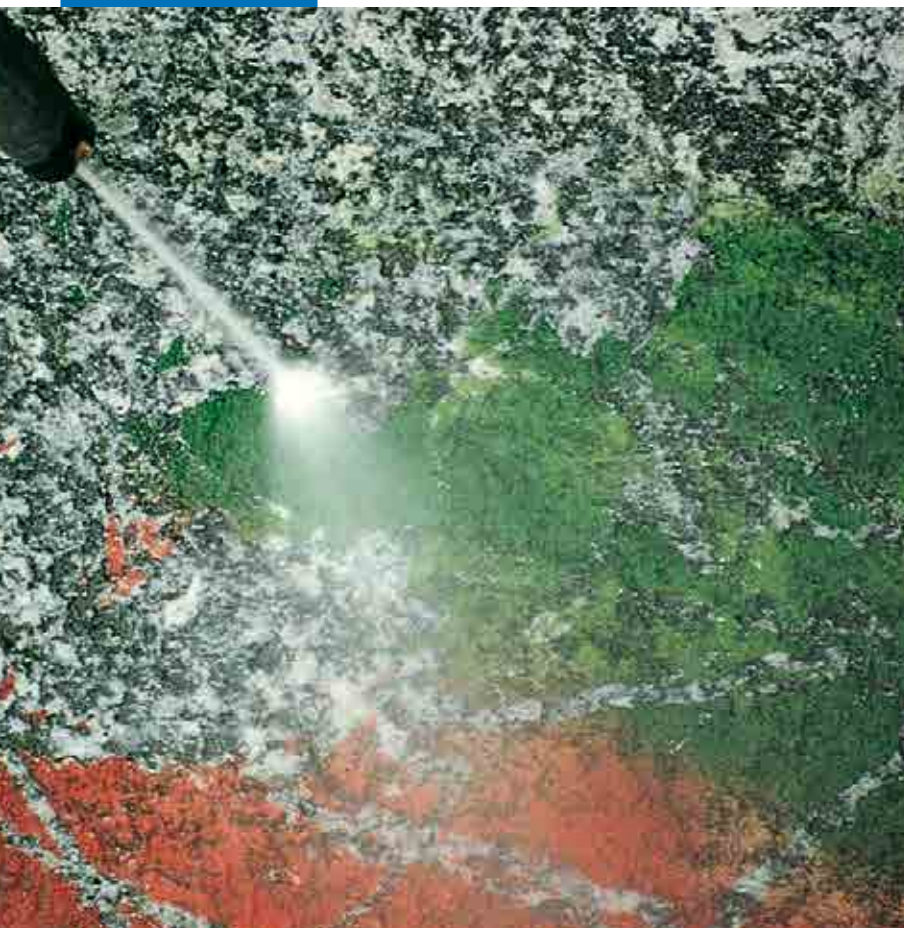
Bruk av høytrykkspyler på granitt, behandlet med WallGard Graffiti Barrier
