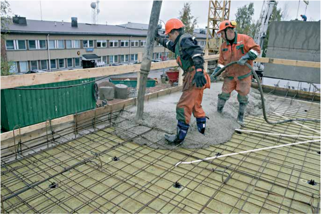
Isoleringen legges i formen.
