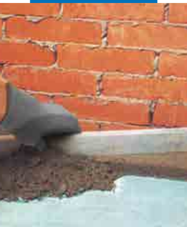
Påføring av sementholdig avretting med Planicrete- blanding
