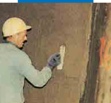
Sementpuss med Planicrete - Ville Marie motorveitunnel, Montreal, Canada
