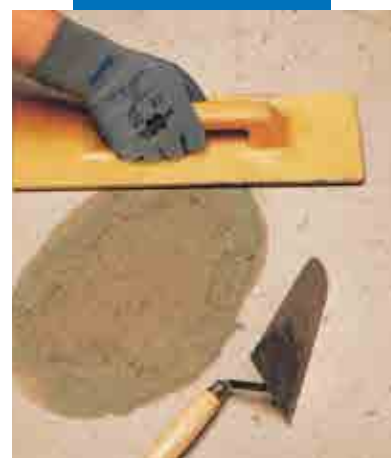
Gulvreparasjon: utglattning til slutt
