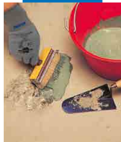
Gulvreparasjon: påføring av slam
