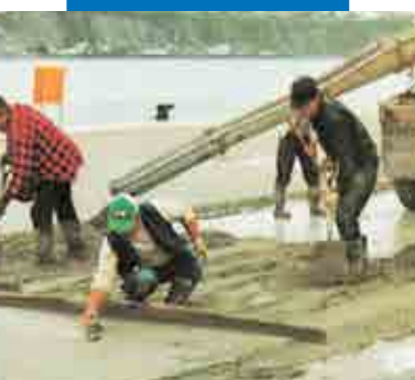
Utvendig sementholdig avretting med Planicrete - Vieux Port, Quebec, Canada
