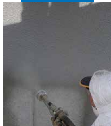
Påføring av Mapelastic med sprøyte på bru
