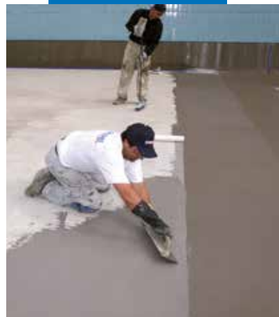
Vanntetting av svømmebasseng med Mapelastic
