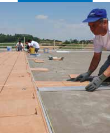
Legging av fliser med Kerabond + Isolastic
