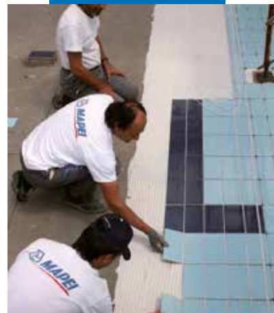
Legging av fliser med Mapelastic i svømmebassen
