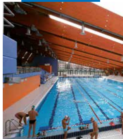
Svømmebasseng vanntettet med Mapelastic: Scarioni Leisure Centre - Milan - Italia
