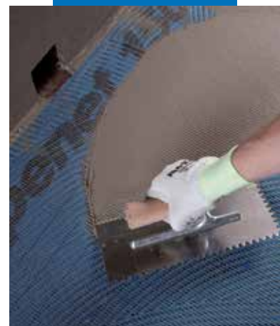
Påføring av Mapelastic over Mapenet 150
