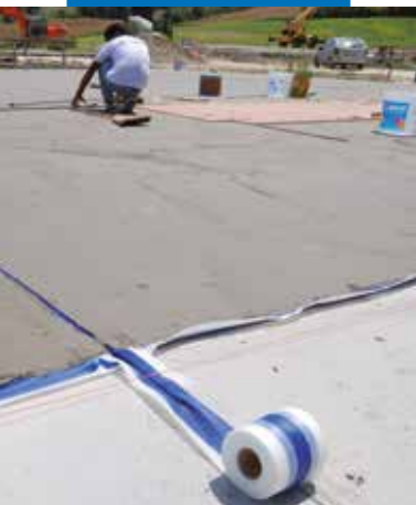
Vanntetting av underlag med Mapelastic og Mapeband
