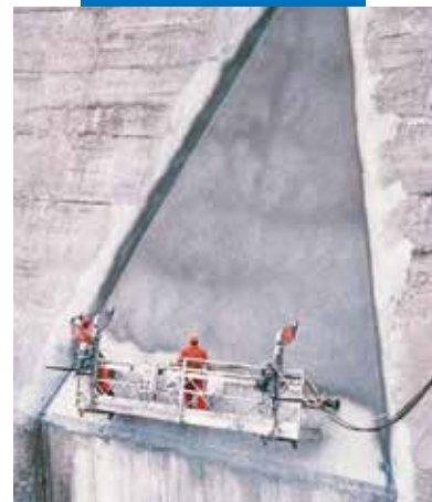
Påføring av Mapelastic med sprøyte på damanlegg
