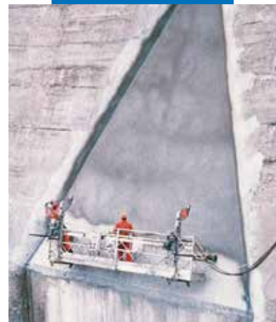
Påføring av Mapelastic med sprøyte på damanlegg
