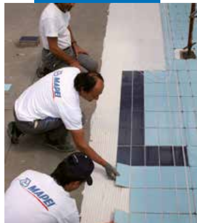
Legging av fliser med Mapelastic i svømmebassen
