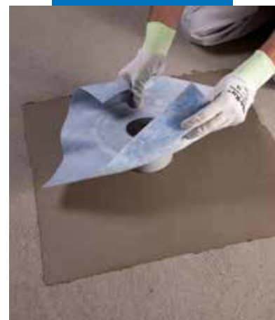
Installering av slukmansjett med Mapelastic
