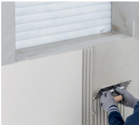
Installering av storformat fliser
