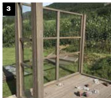
Elementer - start med et hjørne. Skrus fast i hverandre.
