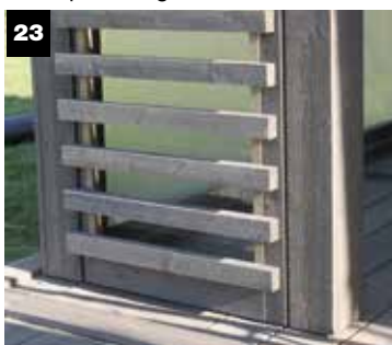
Skrus på sprosseskassett på glass-element
