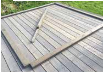
Mål opp, sjekk diagonaler og legg ut alle bunnsviller til eksakt plassering
