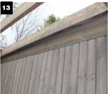
Over skillevegg: Ekstra sperre sørger for tetting mellom rommene. Skrus fast
