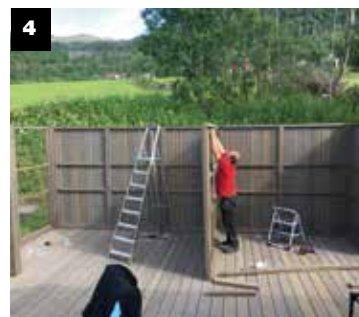
Plasser og skrus sammen alle vegg-elementer
