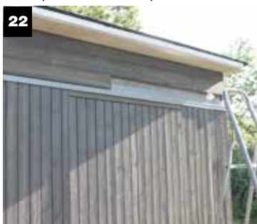
Skrus på dekkbord front samt hjørnebeslag
