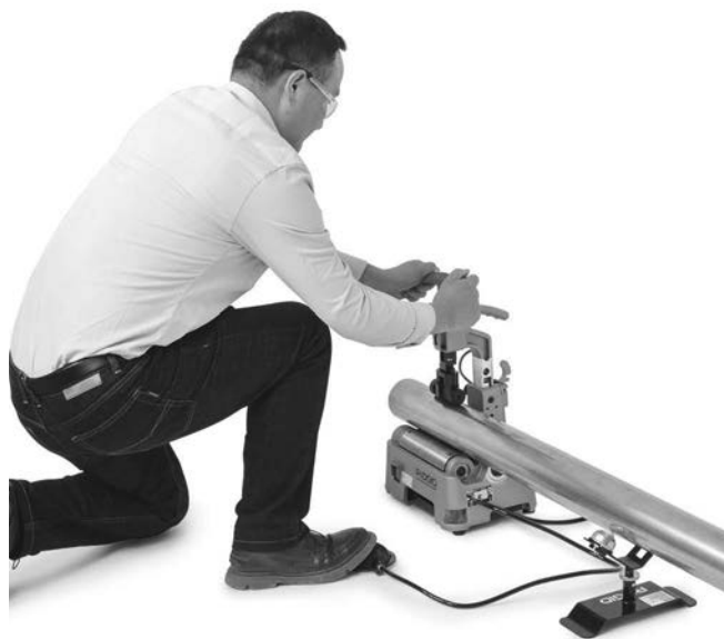
Figur 10 – Kutting av rør
