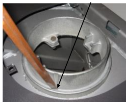
Slå hull med en meisel eller lignende.
